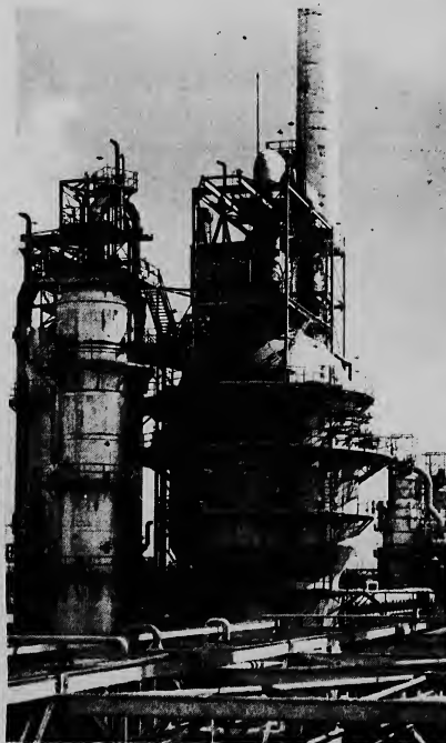
E katalytische kraakinstallatie
